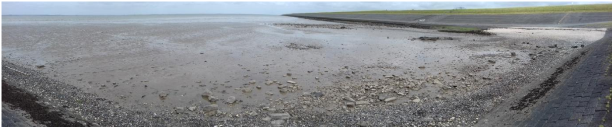
Aanblik van de huidige situatie (naar het oosten kijkend) van het droogvallend wad, de beoogde locatie van het zandstrand.
