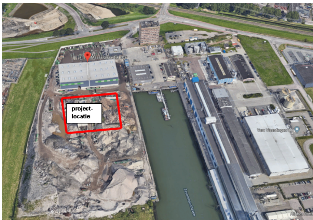
f1.1 De geplande locatie voor de WKK-installatie
