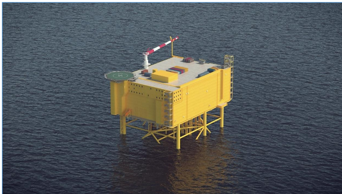
Figuur 2-1 Artist's impression van een 2 GW platform voor IJmuiden Ver (met een stalen draagconstructie)
