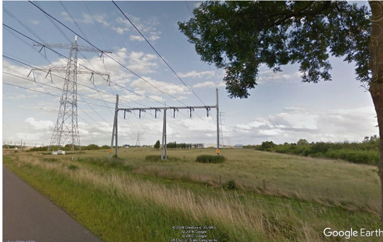
Aandachtspunt: Onderdoorgang spooraansluiting onder hoogspanningslijn (bron: Google Earth)
