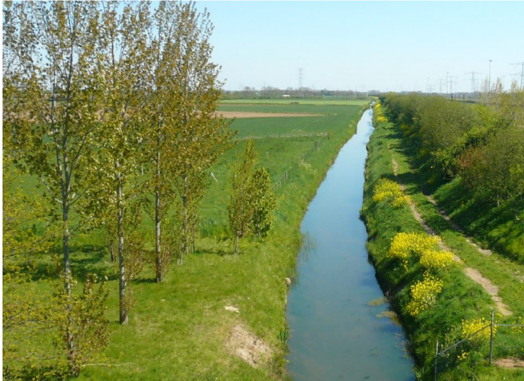
Figuur 6. Foto genomen vanaf de Tielsestraat, ter hoogte van de brug over de Betuweroute en de A15. De bestaande grondwal ten westen van het CUP en ter hoogte van de wijzigingslocatie is hier zichtbaar. De A-watergang en het onderhoudspad ten noorden van de grondwal zijn ook goed zichtbaar. (Bron: landschapsplan RTG)
