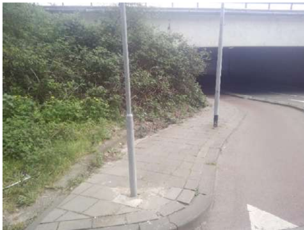
Fotonummer: 25 Omschrijving: Boring 037
