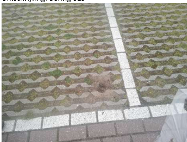
Fotonummer: 15 Omschrijving: Boring 024A
