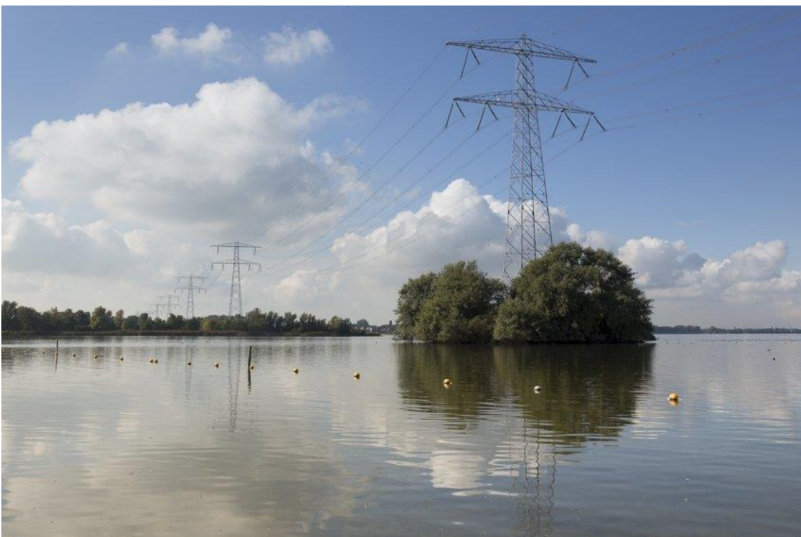
Figuur 6: Indruk van de bestaande 380kV-verbinding tussen Diemen en Lelystad
