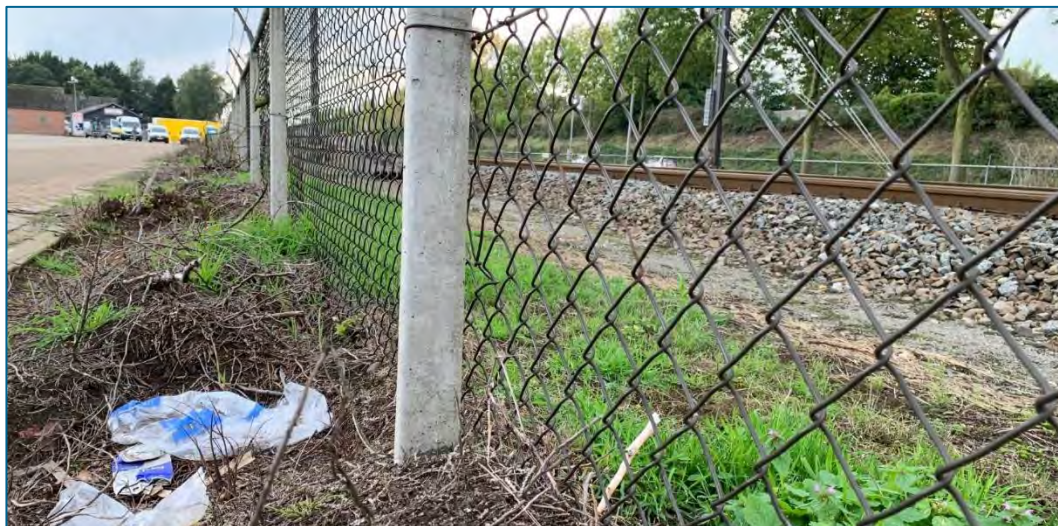
Afbeelding 5.3: Perceelsgrens en afschot tussen spoor en gebied rechts.
