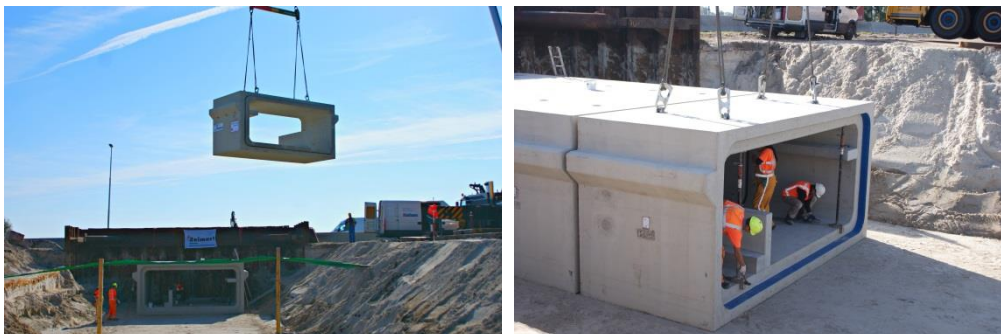
Foto: Op 29 september 2015 werden de eerste tunnelelementen aangelegd (foto Wetterskip Fryslân)
