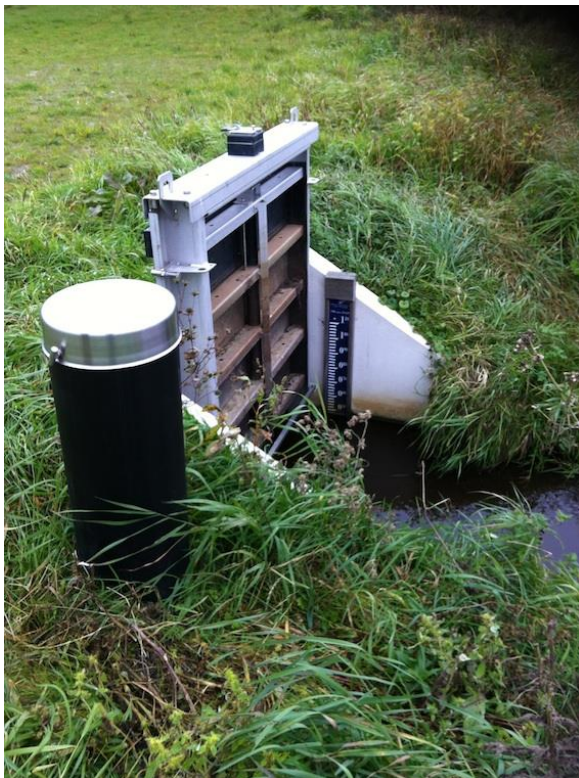
Foto: Inlaatwerk van de nieuwe bedding met meetpunt voor oppervlaktewater bij De Poasen (links) en achterzijde van het inlaatwerk (rechts) (foto's Roy Laseroms)
