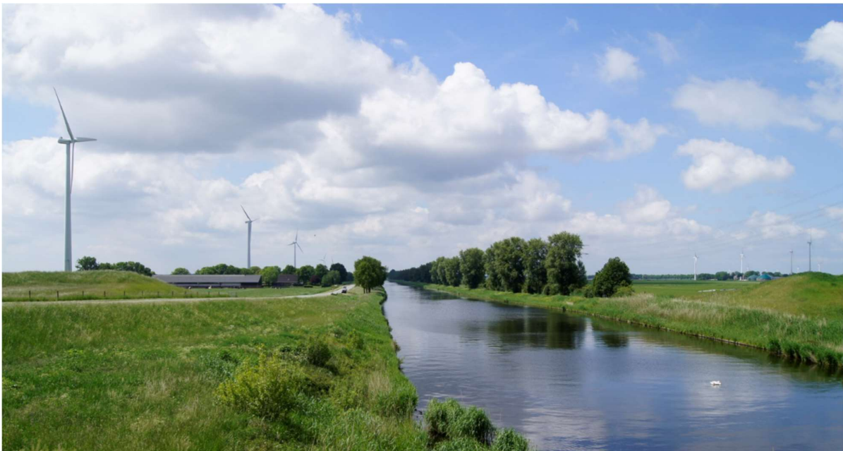
Figuur 13-4: Huidige situatie aan weerszijden van de Hoge Vaart, vanaf de Hoge Knarsluis
