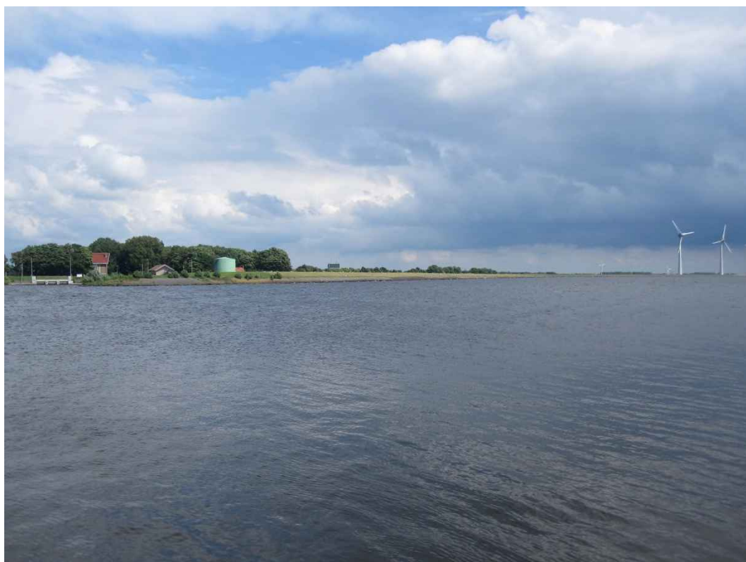
Zicht vanaf de uitkijktoren op de strekdam
