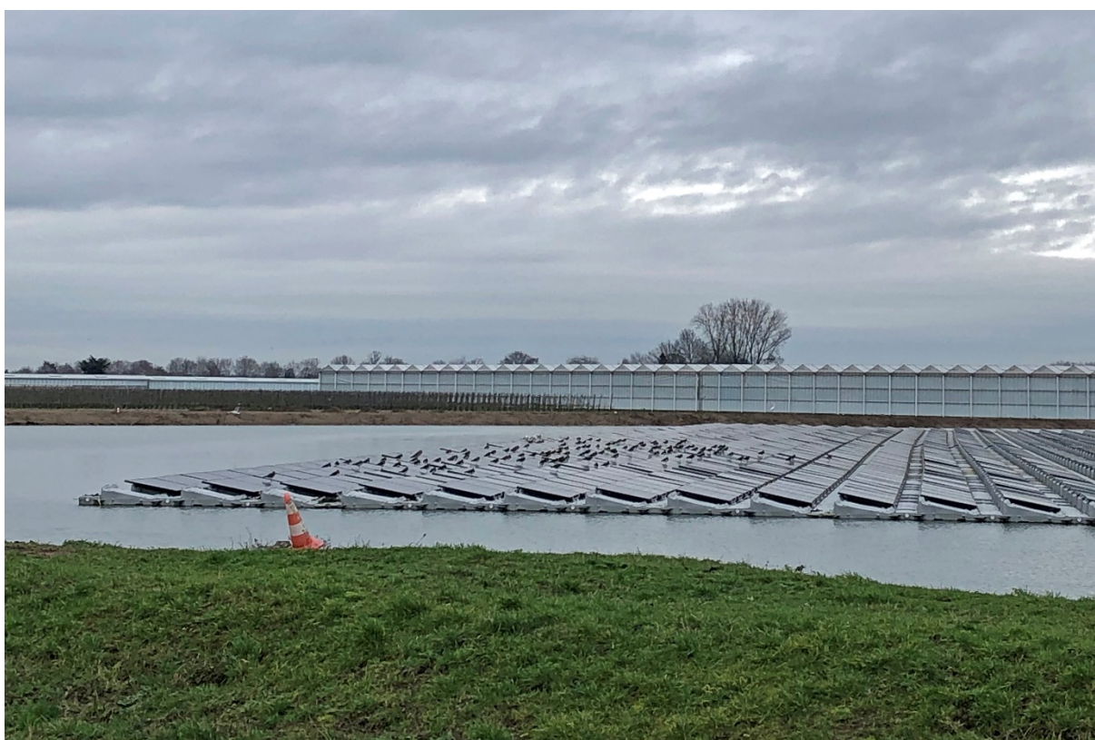
Foto 8.4 Kieviten die rusten op drijvende zonnepanelen bij Elst in januari 2020 (foto Harvey van Diek).
