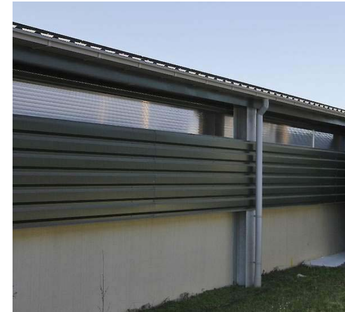
voorbeeld gevelopbouw met winddrukcap
