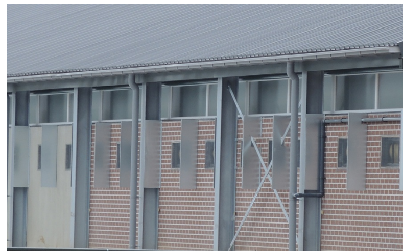
voorbeeld gevelopbouw met ventilatieopeningen
