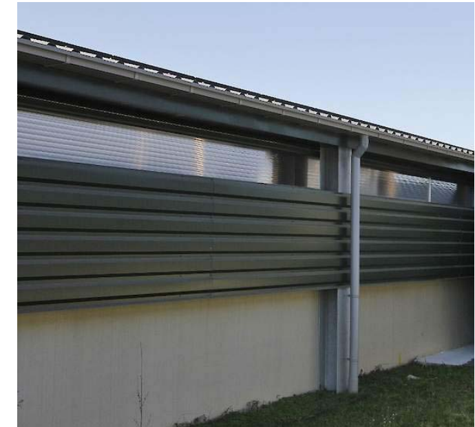
voorbeeld gevelopbouw met winddrukcap
