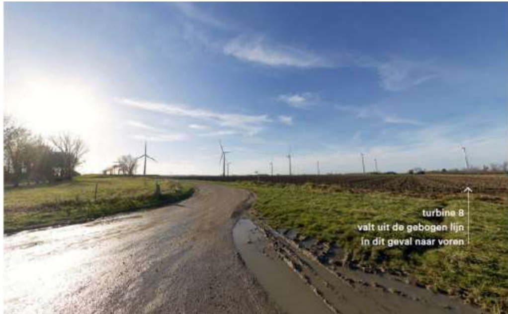
Figuur 5.8 Visualisatie standpunt 2 (Sint Martijnsweg) - Windpark ZE-BRA bestaande uit windturbines met een rotordiameter van 160 meter en een ashoogte van 120 meter
