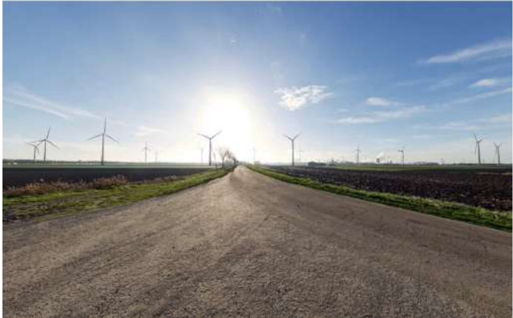
Figuur 5.12 Visualisatie standpunt 3 (Nieuwe Dijk, nabij snelweg A4) - Windpark ZE-BRA bestaande uit een mix van turbine-klassen met een rotordiameter van 140/150 meter en ashoogte van 125/130 meter
