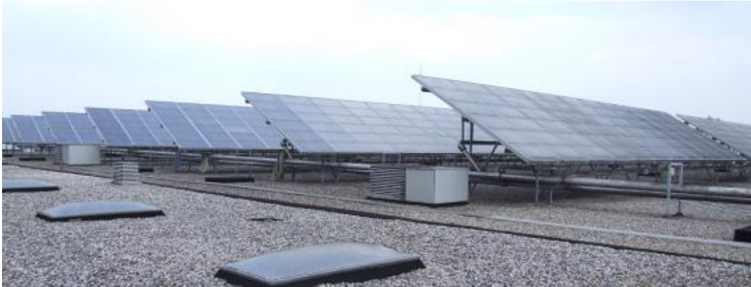
Figuur 8. Zonneboiler op het dak van Perfetti Van Melle voor de productie van Mentos.
