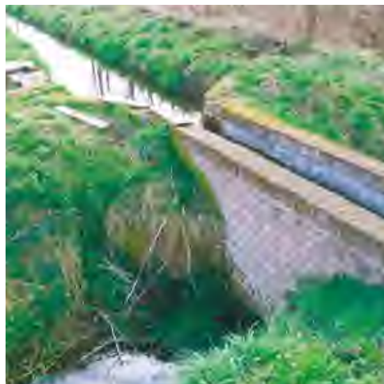
Referentiebeeld: Mini aquaduct om watertypen te scheiden, het Plateaux, Valkenswaard
