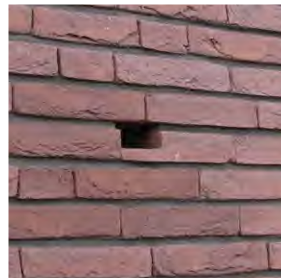
Invliegopeningen zodat de schuur toegankelijk is
