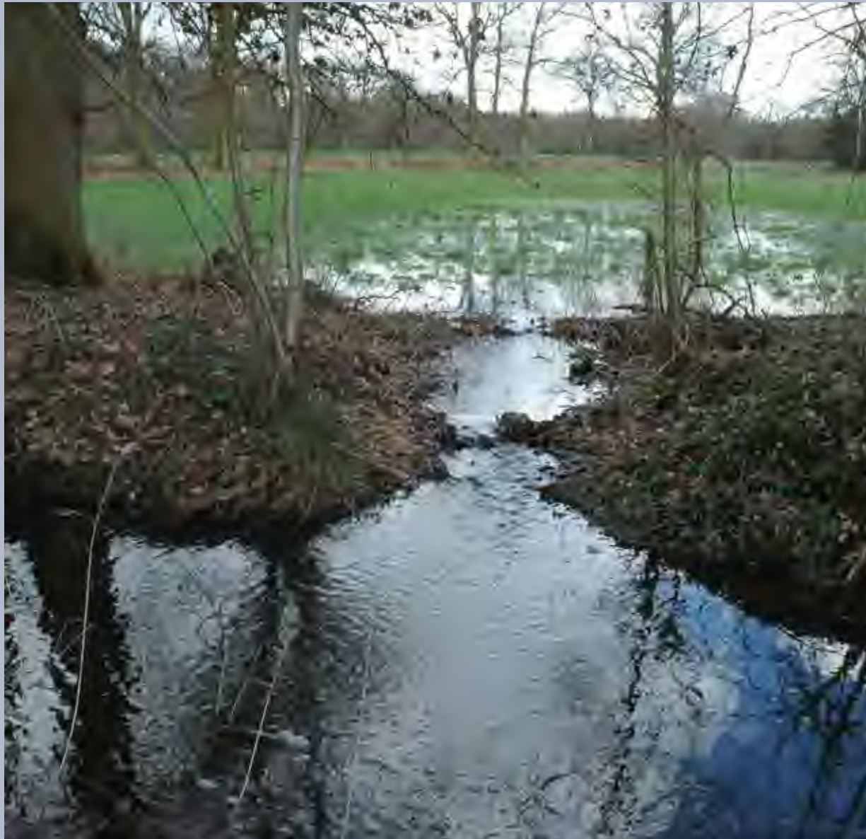
Principe van verlaging in de houtwal om bevoeiing vanuit de laak of kwelzone mogelijk te maken
