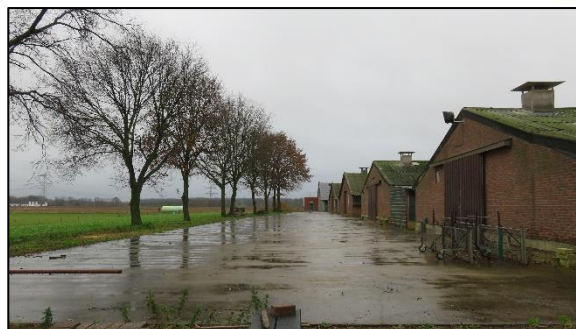
Foto 2. Het noordoosten van de vier te slopen stallen
