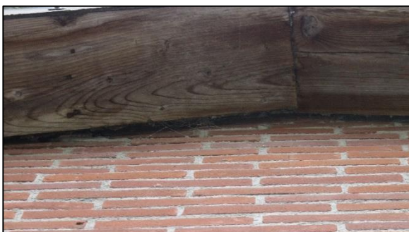
Foto 5. Ruimte tussen de dakrand en de muur
