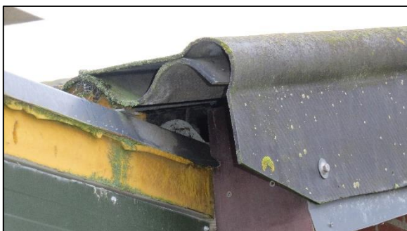
Foto 3. Opening onder de dakplaten
