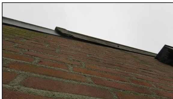
Foto 6. Ruimte tussen de dakrand en de muur
