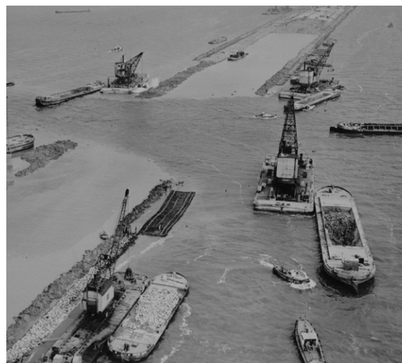
Sluiting van de ringdijk Oostelijk Flevoland. Bron: Beeldbank Rijkswaterstaat
