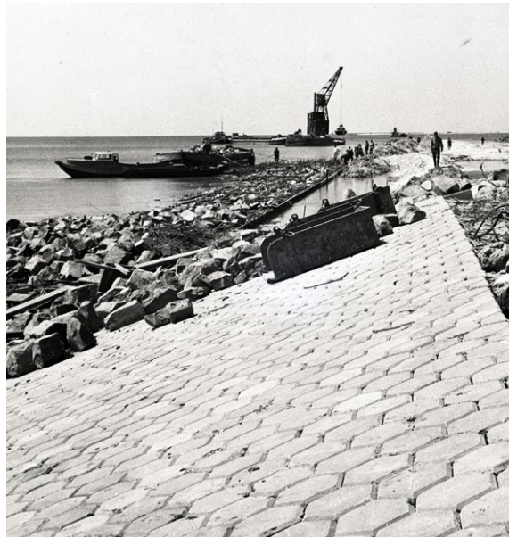
Uitvoeringswerken van de dijkbekleding ten tijde van de aanleg van de IJsselmeerdijken (Beeldbank Rijkswaterstaat)
