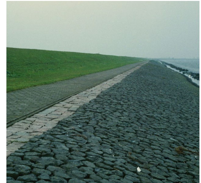
Een beeld van de huidige situatie: de kenmerkende obstakelvrije, oneindige dijken bestaande uit stortsteen en grastaluds (Beeldbank Rijkswaterstaat)
