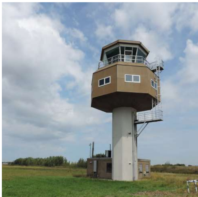
Bestaande verkeerstoren - voormalig Marine Vliegveld Valkenburg
