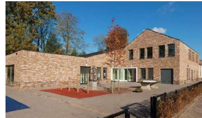
Kleinschalige multifunctionele accommodatie
