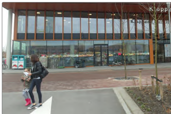
Tijdelijke supermarkt in multifunctioneel gebouw
