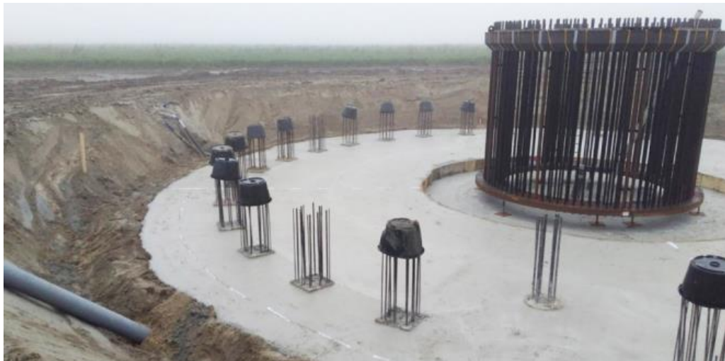
Figuur 3.2 Ankerkooi en wapeningsstaal heipalen
