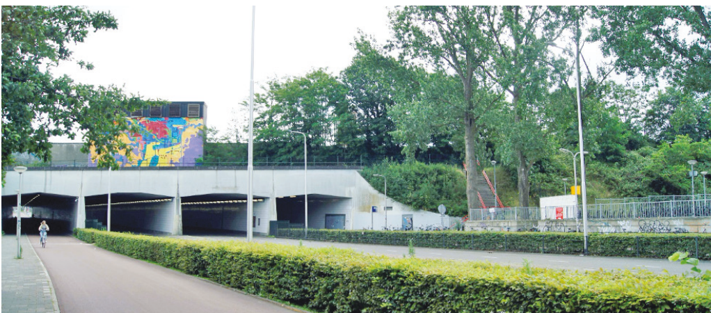
Figuur 13-12. Huidige situatie visueel-ruimtelijk karakter ter hoogte van de nieuwe westentree
