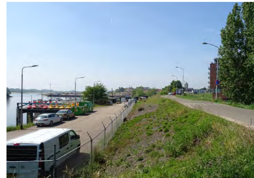
Hek om terrein van brandweer en talud dijk met basalt
