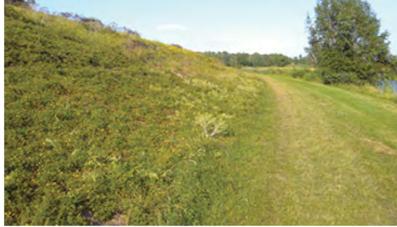
Referentie Eco-deklaag (harde bekleding haven talud): landgoed Loenen (DO-opgave)
