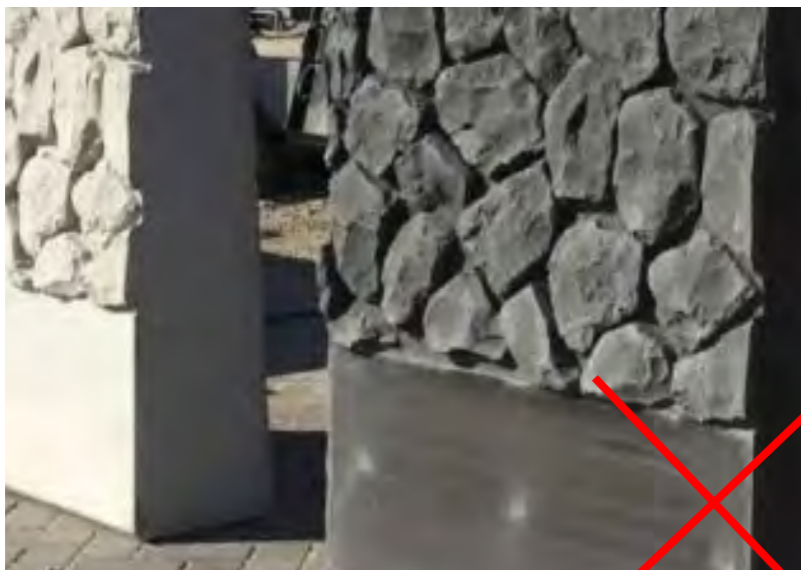
Bekleding kistdam, zo niet: prefab betonelementen té regelmatig beeld en aansluit-naden gaan het beeld bepalen
