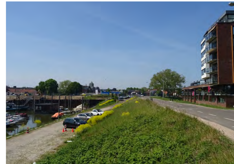
Het buitendijkse parkeerterrein van de haven en een grastalud
