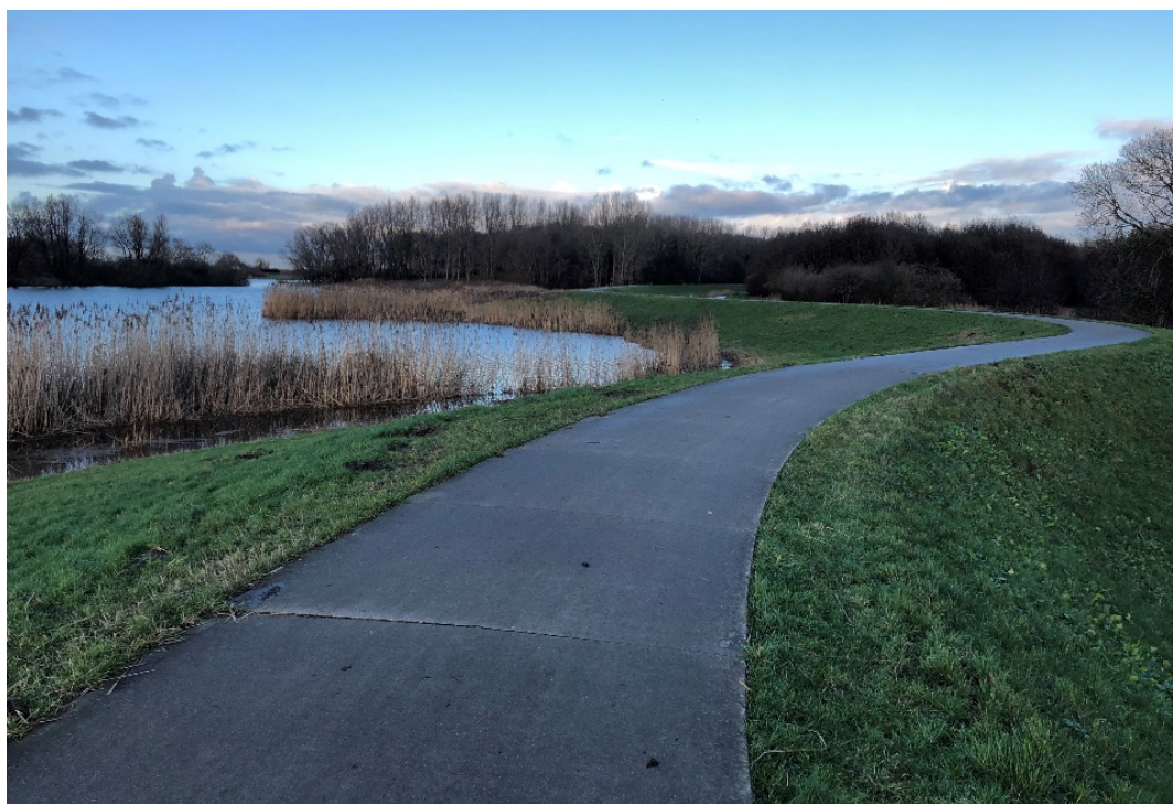
Foto 2.7 Waterkering langs de Westerveldse kolk
