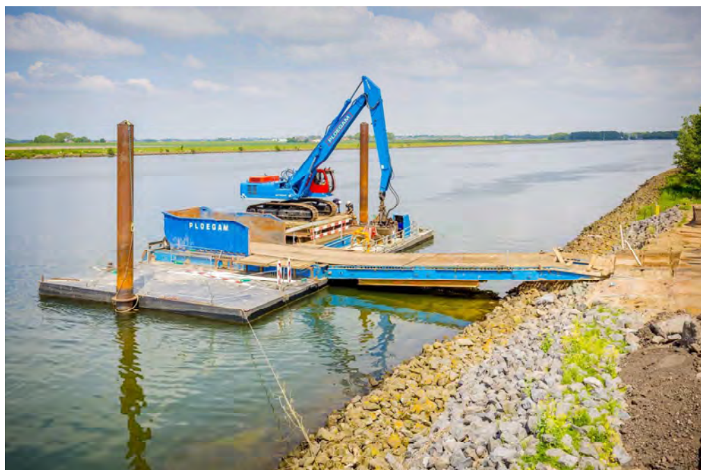
Figuur 8.1 voorbeeld Laad – los voorziening
