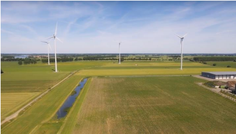
Afbeelding 3.2 Kleine clusteropstelling Windpark Duiven, Gelderland
