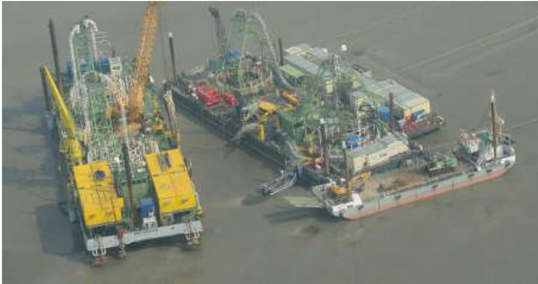
Figuur 1-11 Installatie in ondiepe zeegebieden (nearshore)
