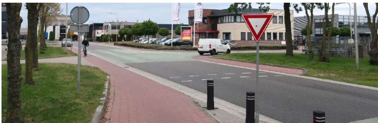
Foto 2-8: Nijverheidstraat tussen Schering en De Blokmat met fietsvoorzieningen
