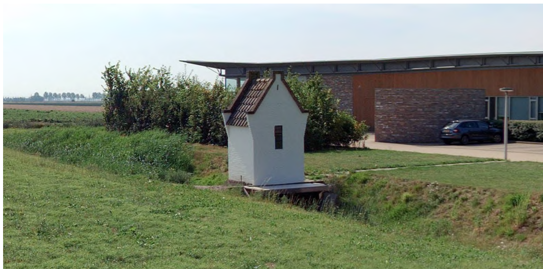
Figuur 10.3: Het pomphuisje nabij Hoofdweg 1126 (bron: Streetsmart Cyclomedia).
