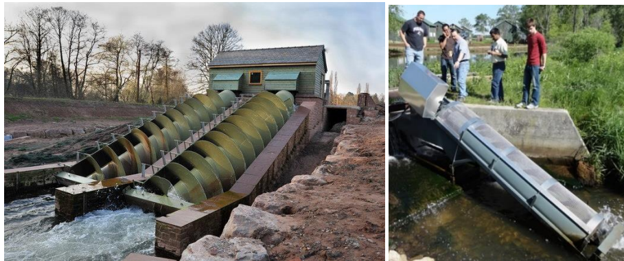
Figuur 7.3: Voorbeeld vijzelturbine (hoog waterpeil verschil)
