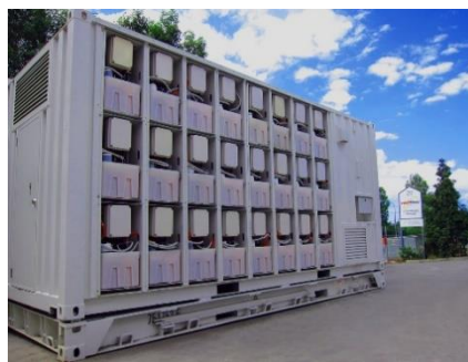
Voorbeeld 'flow' chemische batterij
