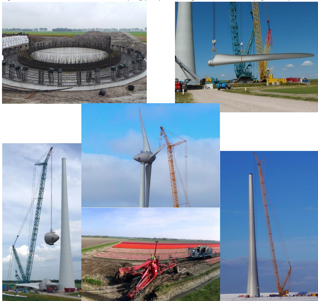
Figuur 2.5 Beelden bouw windturbine en kabelploeg (windpark NOP Agrowind; Bron: www.nopagrowind.nl )
