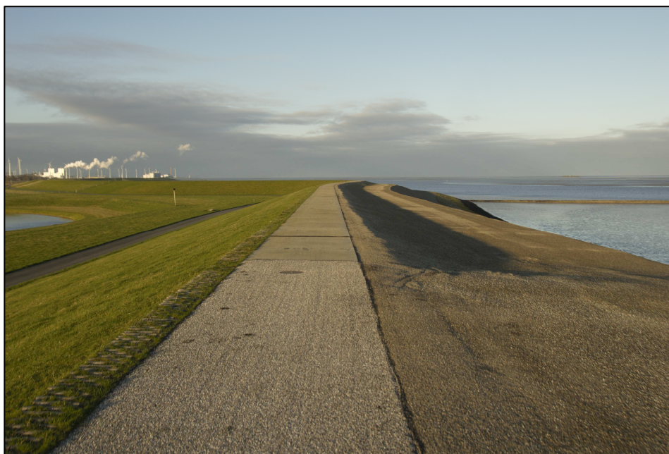
Foto 1 Eindresultaat dijkverbetering: buitendijs verhard, op de kruin een fietspad, binnendijs groen met een verhoogde steunberm
