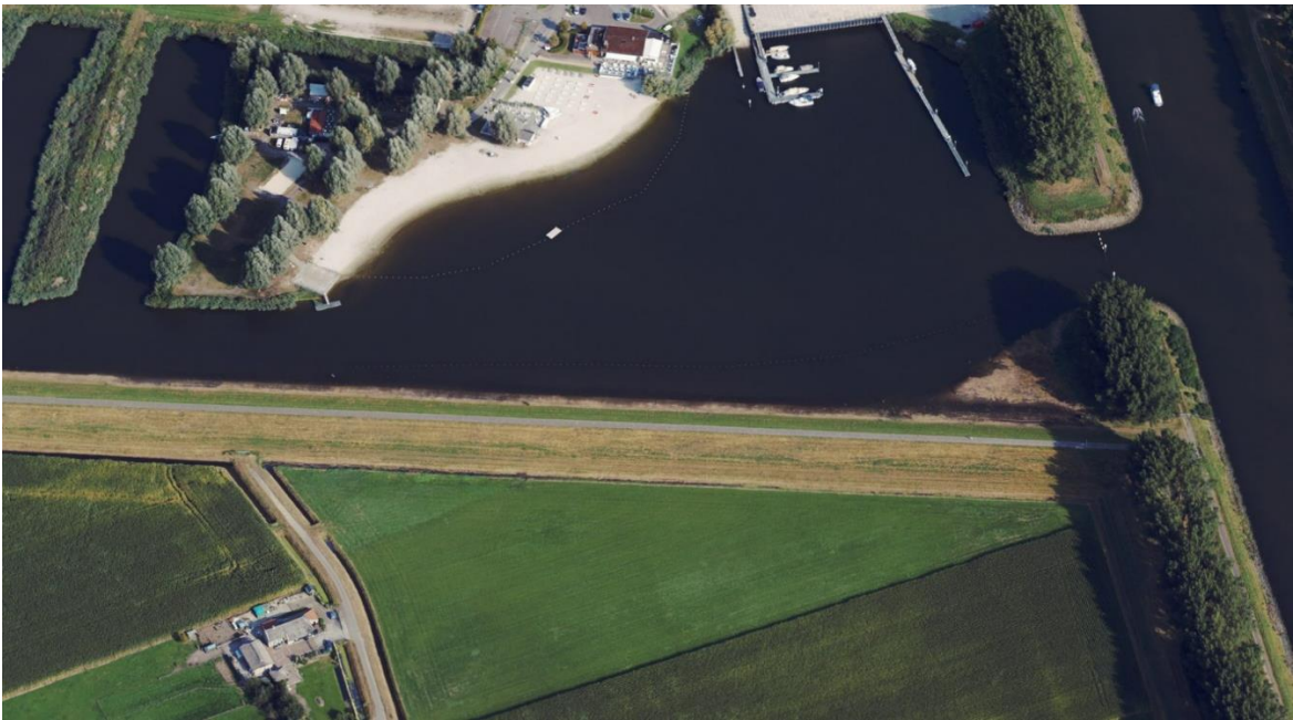
Figuur 2.3: Luchtfoto oostelijk deel Standhazensedijk (StreetSmart)
