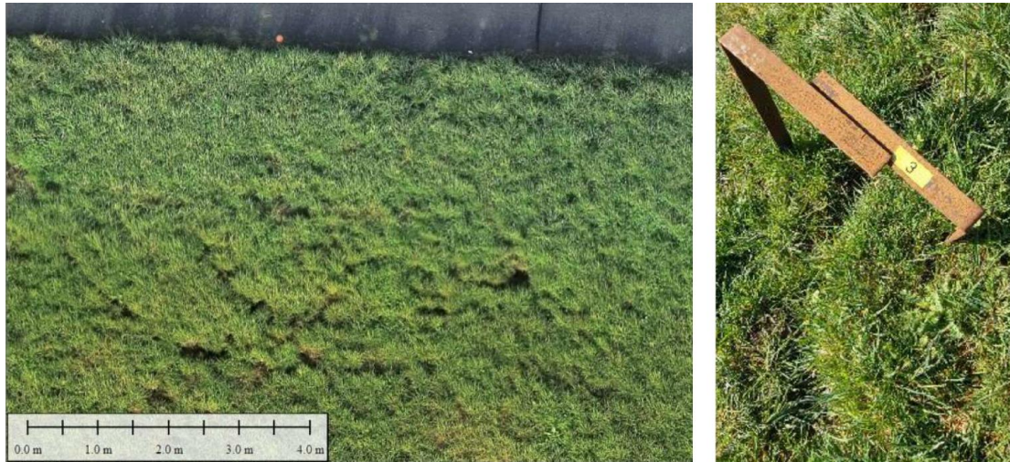
Figuur 2.5 Scheuren in de dijk
