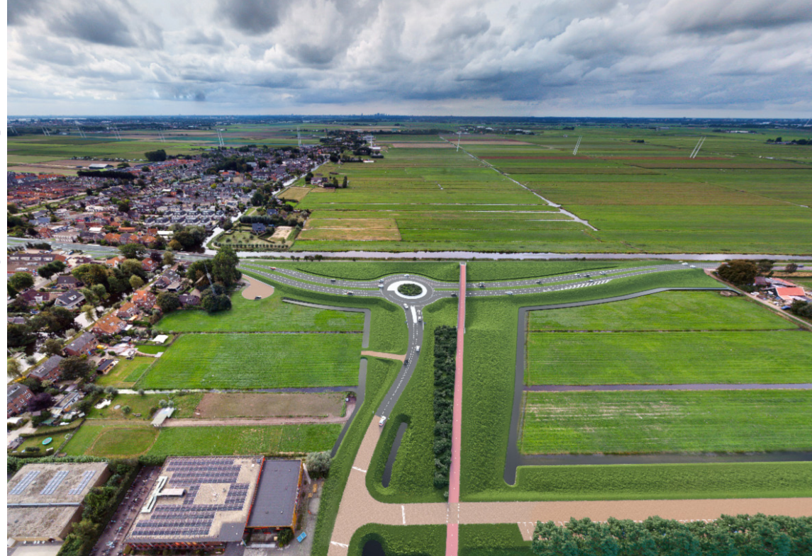
Bovenaanzicht rotonde noord en fietsbrug Hazerswoude-Dorp
