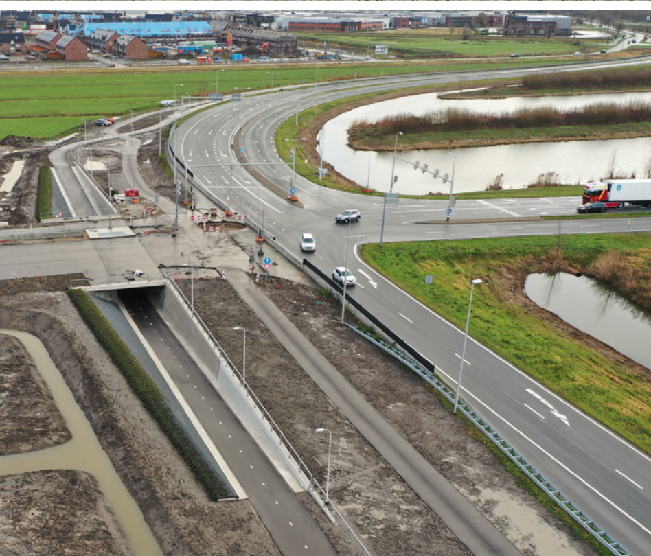
Aanleg Vredenburglaan, kruising N451
