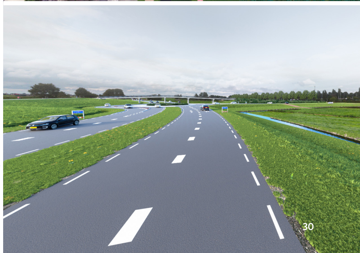
Rotonde noord en fietsbrug
