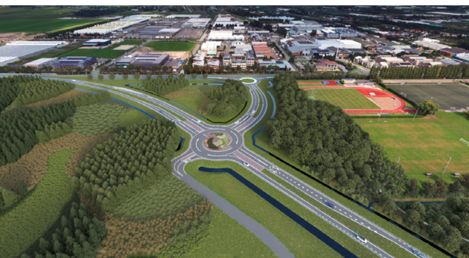
Rotondes sluiten aan op de Hoogeteenseweg
