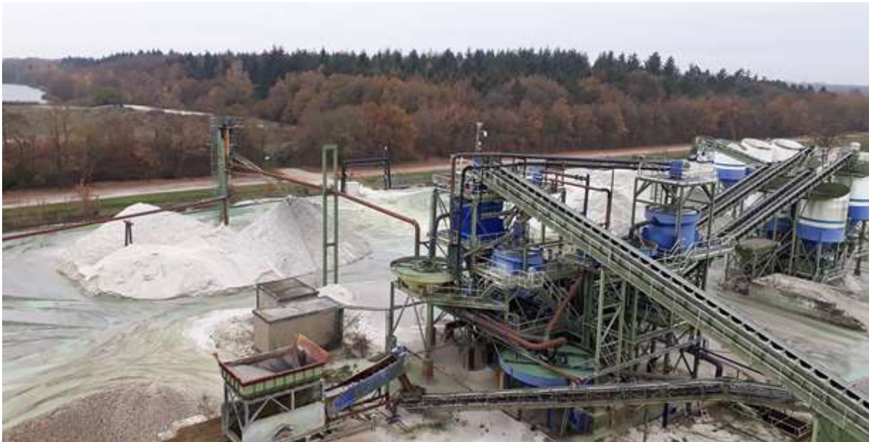
Figuur 4. Foto van de klasseerinstallatie (najaar 2018)
