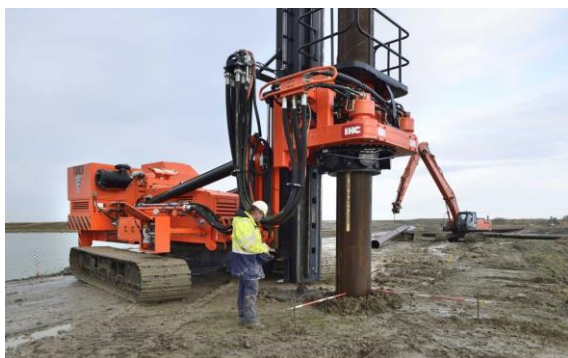
Figuur 4-2: Tubexboorstelling (links) en Silentpiler (rechts)
