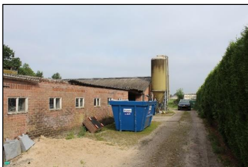
Foto 3. Te slopen varkensstallen
