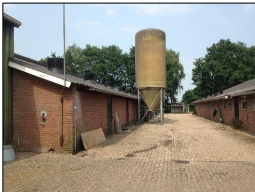
Foto 15. Te slopen varkensstallen
