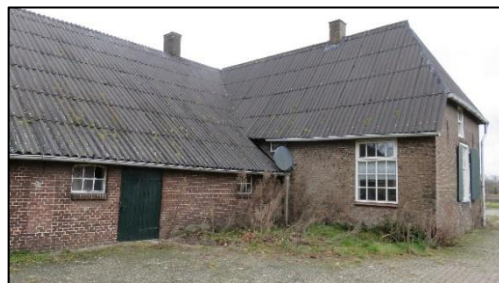
Foto 28. Woonhuis en stalgedeelte
