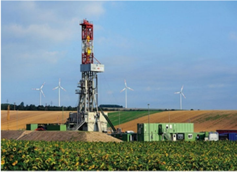
Figuur 5-2: Tijdelijke boorinstallatie.
