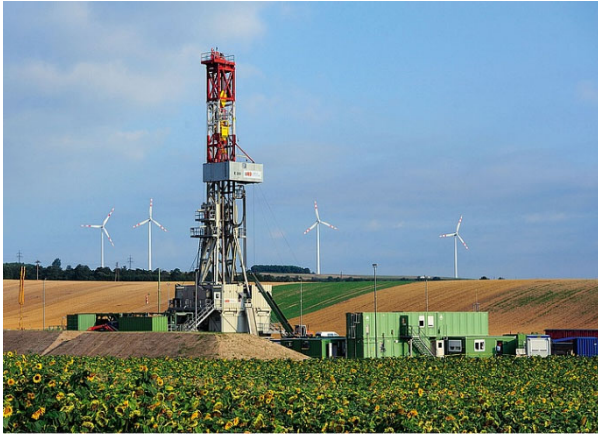
Figuur 6-6: Tijdelijke boorinstallatie.
