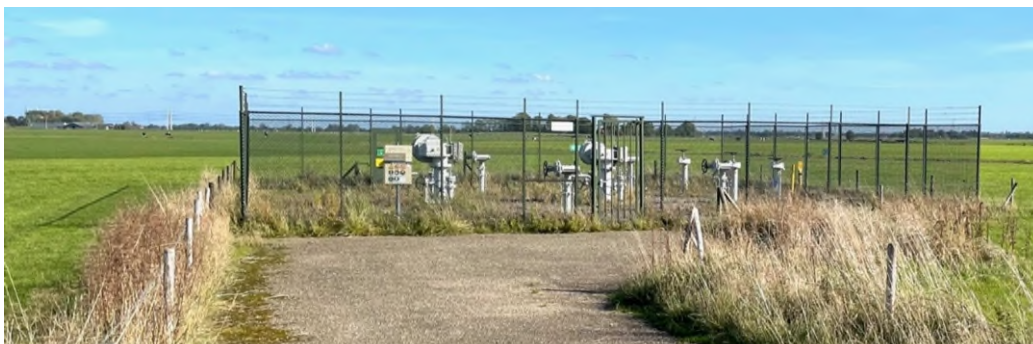
Figuur 3-11 Voorbeeld van een omheinde afsluiterlocatie voor drie parallel gelegen leidingen. Bij één leiding is de oppervlakte 1/3 van deze locatie (Bron: HNS)
