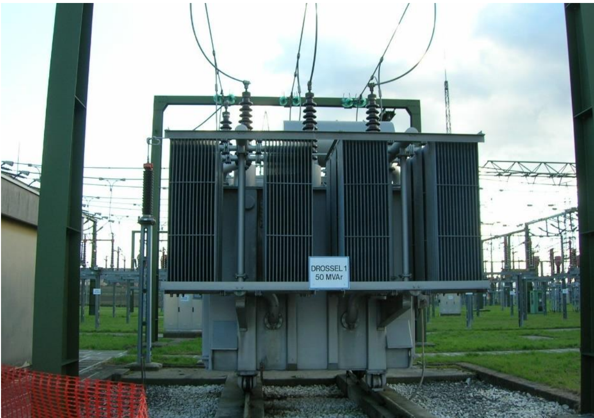
Figuur 4-5. Voorbeeld van een spoel
