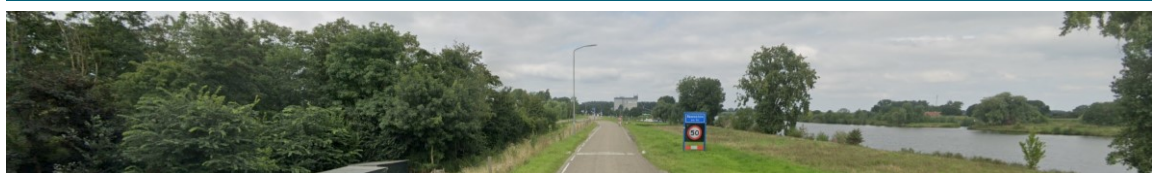
moderne gronddijk van A50 tot Ravenstein
