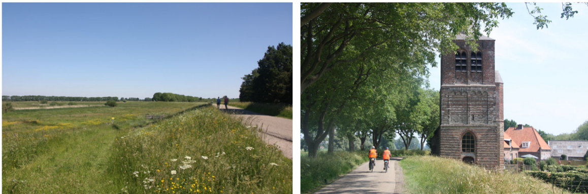
Figuur 2-3: Moderne gronddijk (links) en tuimeldijk met notenbomen (rechts).
