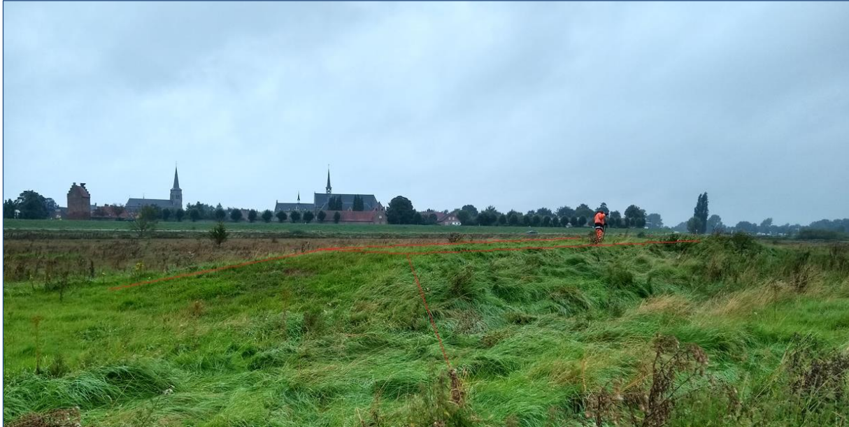
Figuur 19. Restant van het voormalig dijkklichaam dat huis Maasakker tegen hoogwater moest beschermen. Met dunne rode lijn zijn de contouren aangeduid. Bovenop de dijk is boring 13 gezet die het dijkklichaam bevestigt.
