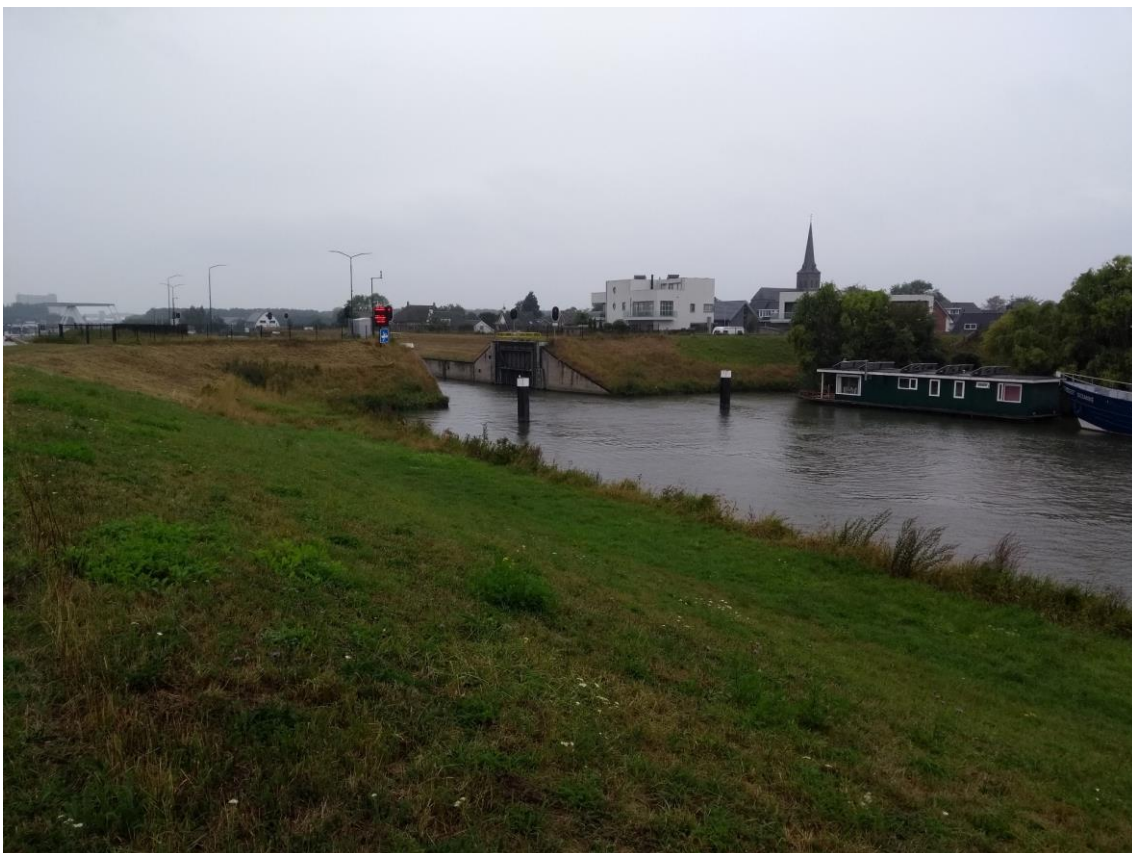
Foto 2. De primaire waterkering richting de sluis naar Oss.
