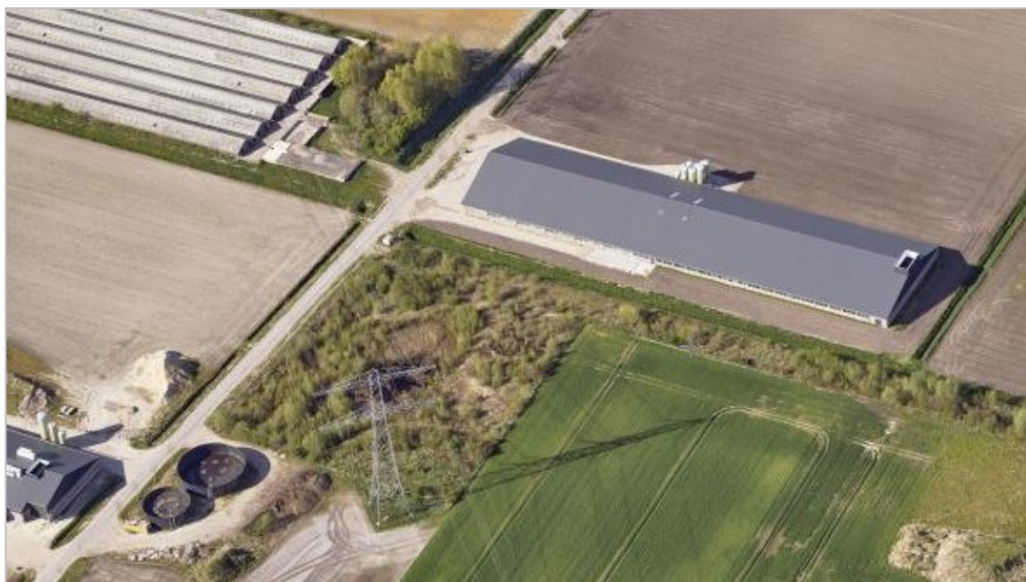
Figuur 6: Luchtfoto zeugenstal op De Horsten 17 in deelgebied 3. Ten zuiden van de stal het stuk perceel onder de hoogspanningslijn dat is gericht als waterbergingsvoorziening (Bron: App Slagboom en Peeters, obliekviewer, 18 april 2022)
