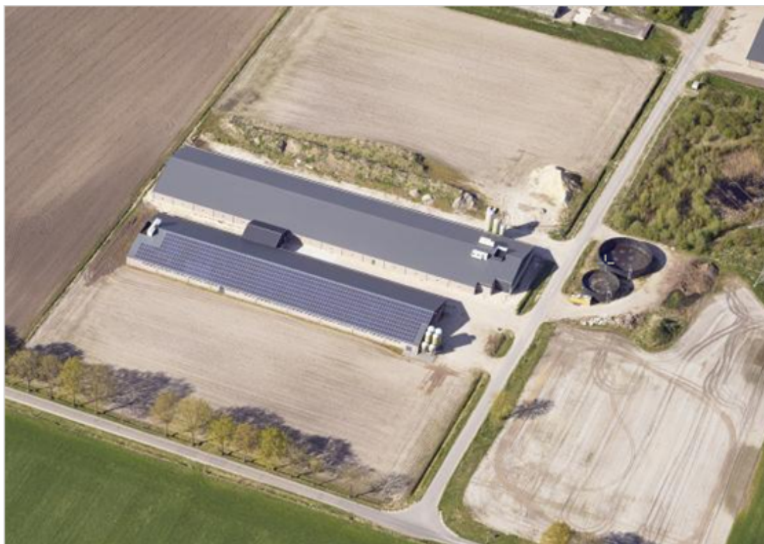
Figuur 9. Luchtfoto biggenstallen op De Horsten 20 in deelgebied 1 (Bron: App Slagboom en Peeters, obliekviewer, 18 april 2022)
