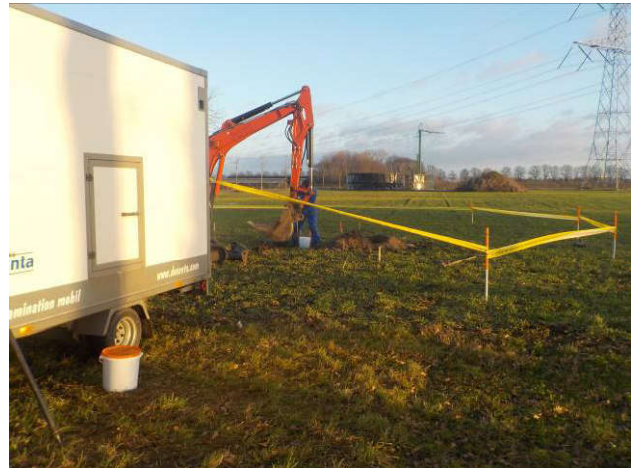
Foto 4: Tijdens locatiebezoek op 21-01-2021 zijn proefsleuven gegraven tpv voormalige oprit nr. 22.
