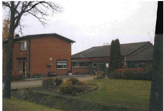
Foto 2: Foto locatie oprit Melkweg 22 in december 2012 (rapport HMB 2012).
