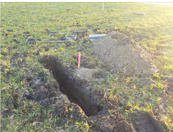
Foto 5: Huidig maaiveld is grasland. In sleuf 01 zijn 2 asbestverdachte plaatjes gevonden (zie foto 6).
