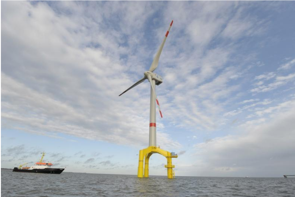
Figuur 2.3 Voorbeeld van een tripile fundatie 2 .
